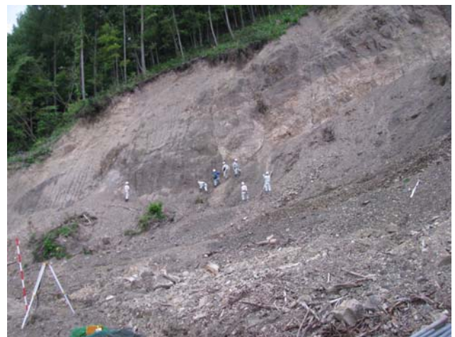
写真-6 地すべり側崖での露頭観察状況
