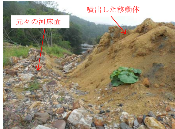
写真－6 移動体が河床面を突き抜けて噴出した様子 （末端隆起部にて）
