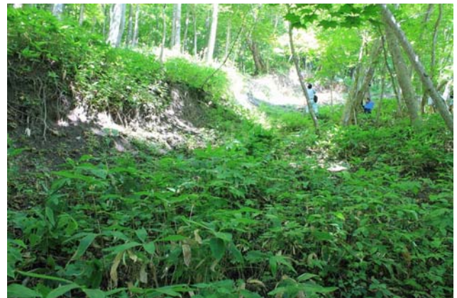
写真-2 藤崎の沢地すべり III ブロックの典型的な滑落崖
