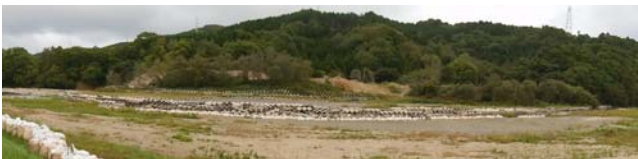
写真－1 後志利別川地すべり全景（対岸より）
