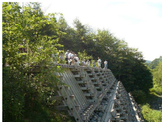
写真-2 長知内地すべり対策工の見学（浸食防止工）
