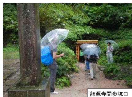
写真-2 落石対策と龍源寺間歩坑口の様子
