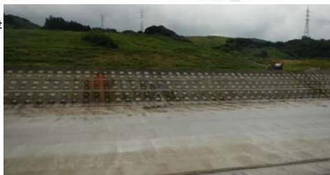
写真-1 斐伊川放水路の法面変状と対策後の様子
