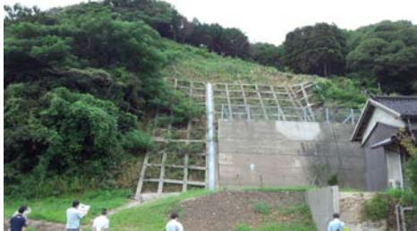
写真-1 恵曇町落石対策現場全景
