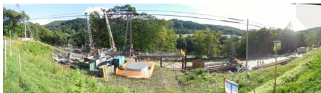
写真-5 対策工施工の様子
