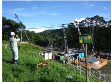
写真-3 施工中の集水井
