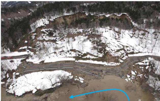
写真-1 発生直後の霧立地すべり
