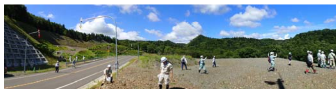
図- 3 地すべり（写真左奥）、国道（写真左）、抑え盛土（写真中央から右）
