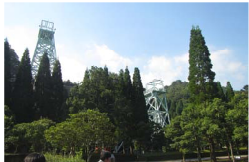
写真-4 縦坑櫓と周辺の山並み
