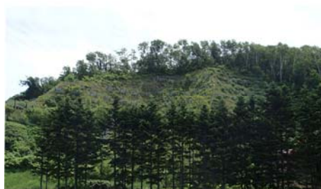
図- 1 古丹別神社背後の表層崩壊跡
