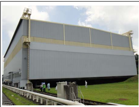
写真-1 防災科学技術研究所大型降雨実験施設全景
