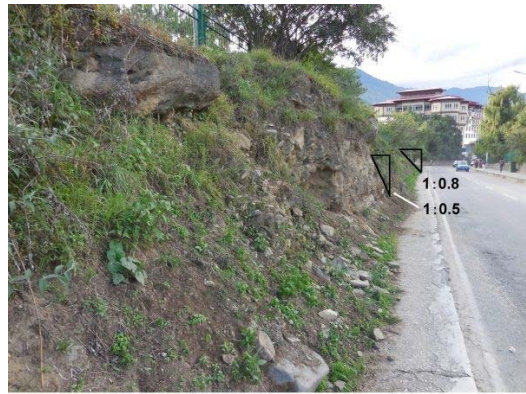
写真 5. 土砂のり面例 (保護工等なし、小康状態)
