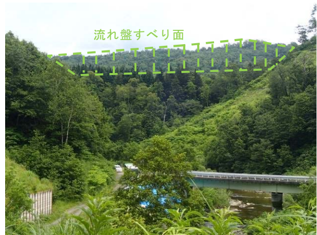
写真-2 流れ盤すべり面と移動土塊
