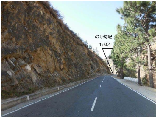
写真 4. 岩盤のり面例 (保護工等なし、小康状態)
