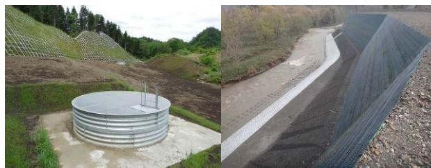
写真－6 集水井工（左）と押しえ盛土工（右）
