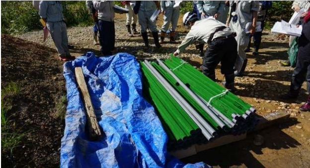
写真-4 施工予定の植毛パイプ
