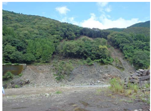
小島地すべり全景
