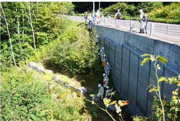
写真-1 地すべり対策工（EPS+アンカー付抑止杭工）
