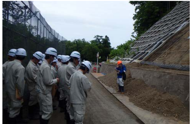
写真-1 地すべり防災授業 （道民の森 神居尻地区の法面工事見学）
