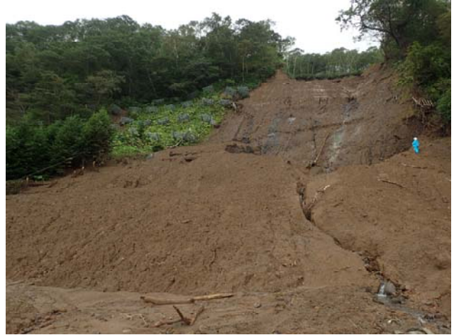
写真-1 下から見上げた羅臼町海岸町の斜面崩壊 凝灰角礫岩の上に礫泥互層がのる。崩壊源はさらにの上で、この位置からは見えない。
