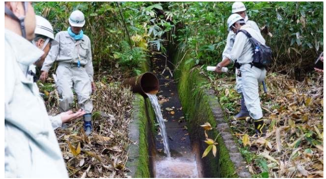
写真-6 φ400mmの排水ボーリング
