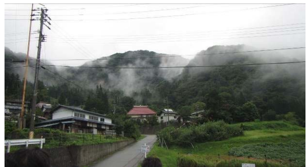
写真-4 崩壊地頭部の斜面
