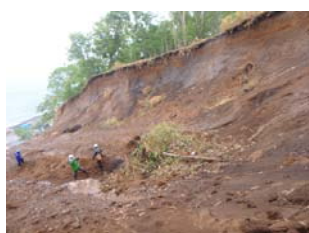
写真-1 崩壊面の状況
