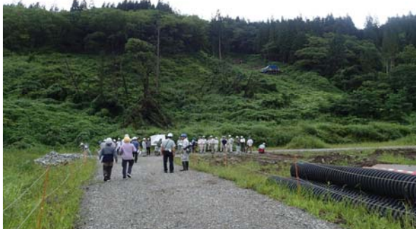
写真-3 八方岩地すべり末端部
