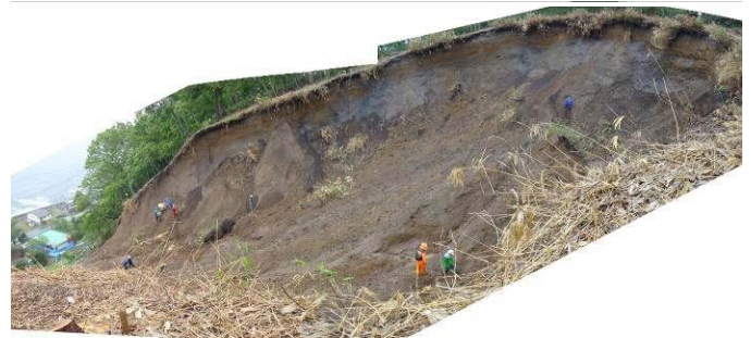
写真-2 滑落崖確認状況
