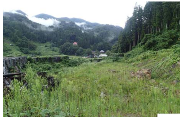
写真-2 カクレ沢えん堤の流木捕捉状況
