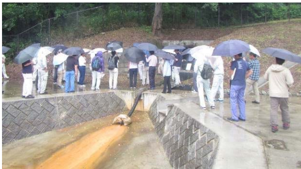
写真-2 排水トンネルと流末の沈澱池
