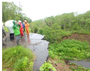
写真-3 道路側の状況
