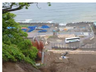
写真-2 崩壊の高さ約 70m
