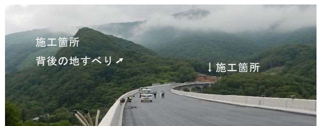
写真-3 朝里地区の全景
