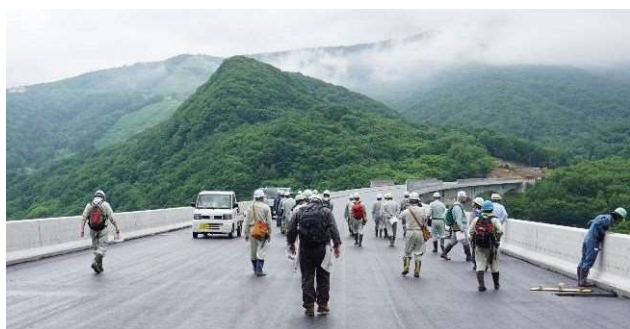
写真-2 朝里地区の地すべり地形
