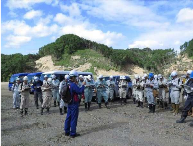
写真-5 対策工事の説明を受ける参加者
