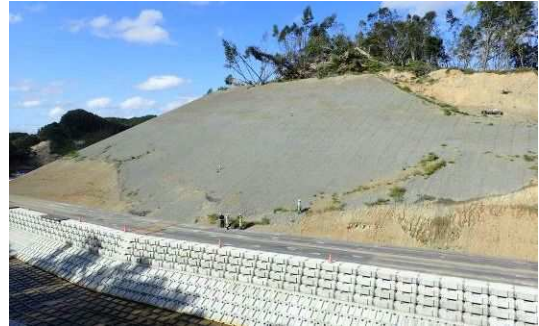
写真-2 河道閉塞部の切土法面
