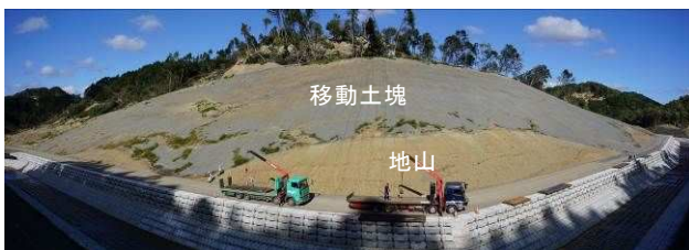
写真-6 地すべり末端部切土法面全景
