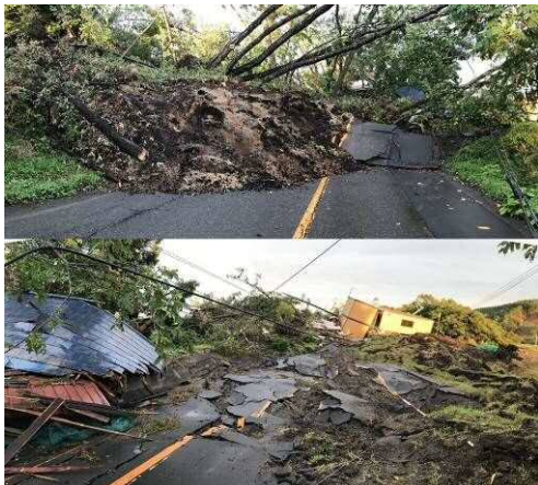
図-5 富里地区 移動体末端部の隆起状況説明資料
