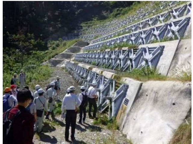
写真-2 アンカー工
