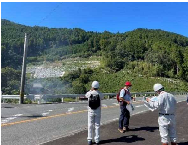
写真-1 葛平地すべり全景
