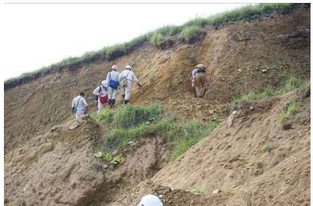
写真-3 串内牧場崩壊地
