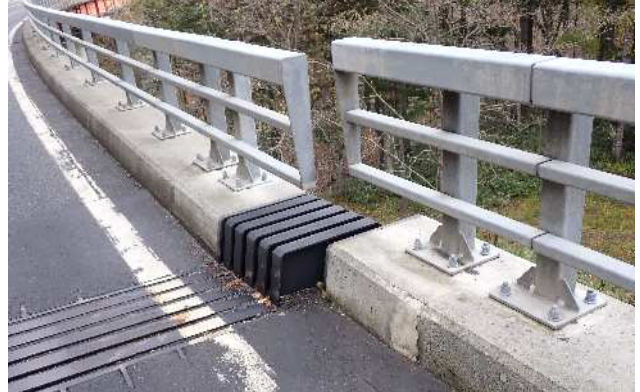
写真-1 福山橋地すべりの活動による伸縮装置部のずれ
